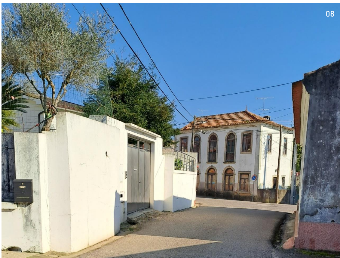
Fotos 07 e 08 – Aspeto da Rua da Corredoura. Tal como a generalidade dos arruamentos no lugar de Fermelã evidencia duas características que importam reabilitar e requalificar. A forte presença da rede elétrica aérea e a ausência de passeios no arruamento.
